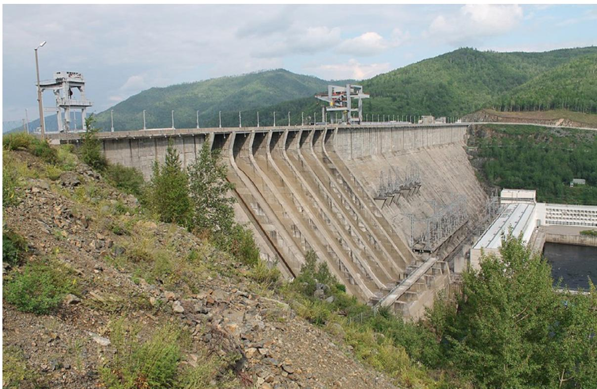
Рис. 16 Массивно-контрфорсная плотина Зейской ГЭС
